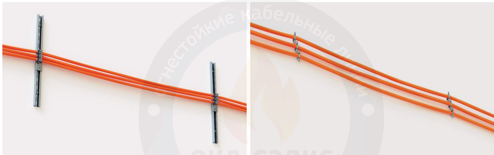
Открытая прокладка кабеля Прокладка кабеля с креплением к С-образному профилю
